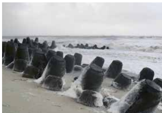
Tetrapodenreihe mit in die Brandung ragendem Querwerk
