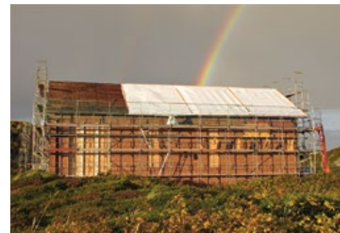
Die künftige „Arche Wattenmeer“ erhält ein neues Dach
