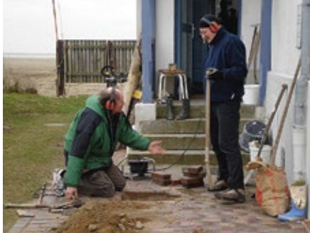
Hans Günther und Uli beim Verlegen einer Wasserleitung zum neuen Stiefelwaschplatz
