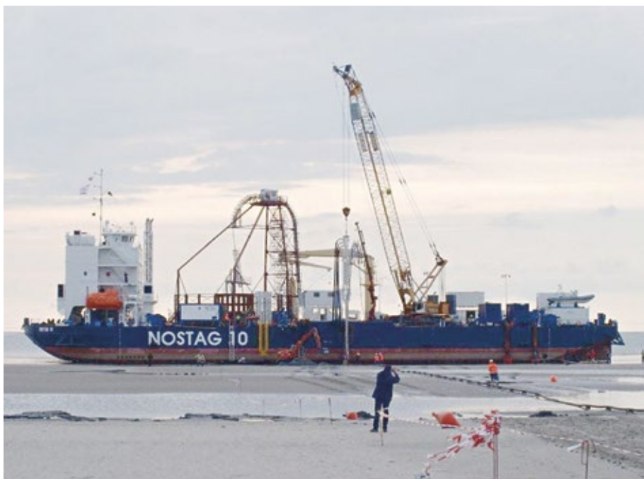
Die Verlegung von Seekabeln ist Großtechnik. Schon zur Verlegung des relativ kleinen Versorgungskabels nach Helgoland war im Sommer 2009 der Einsatz einer über 100 m langen Verlegebarge nötig.
