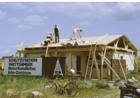
1992 entstand das Dach über den Containern komplett in ehrenamtlicher Arbeit
